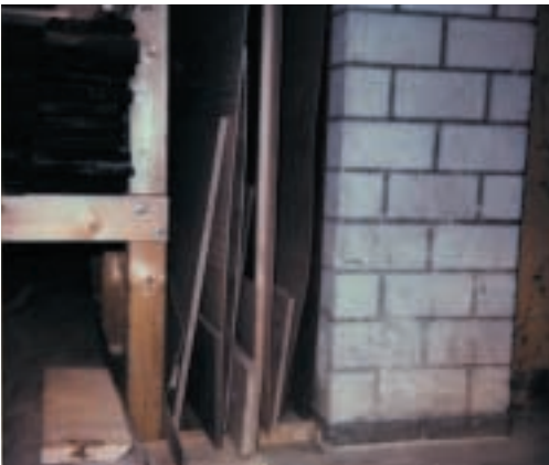
Lagerung von Platten (gegen Wegrutschen gesichert)
