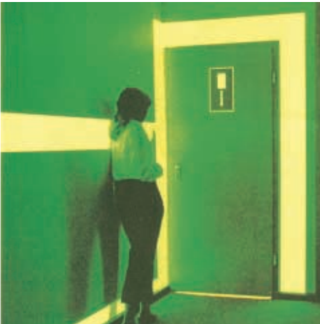
Orientierung durch Nachleuchtstreifen
