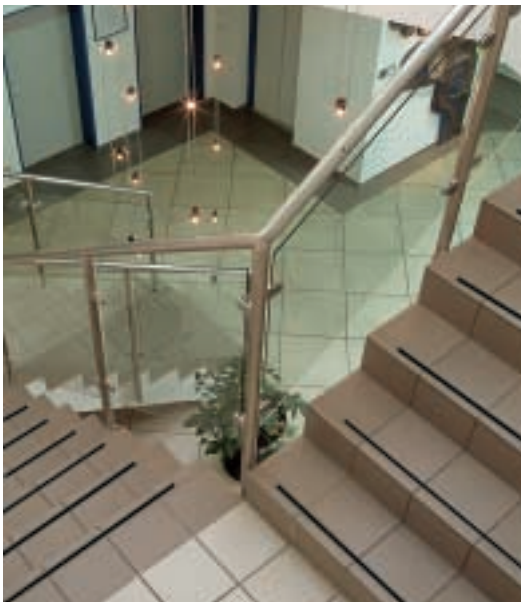
Stufenkante deutlich sichtbar – „Griffiger“ Handlauf
