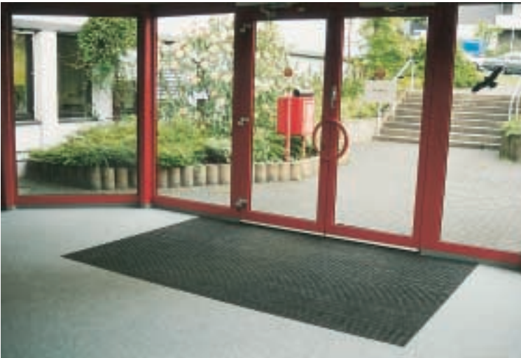
Schmutzfang im Eingangsbereich bodeneben (maximal 4 mm Kante)
